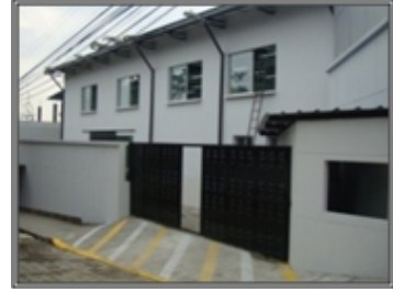
Santo Domingo Construcción de Bodega
