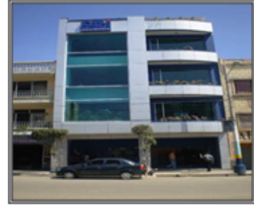
La Libertad. Remodelación Edificio
