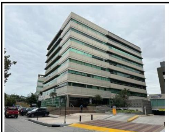
VISTA DEL EDIFICIO
