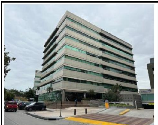
VISTA DEL EDIFICIO
