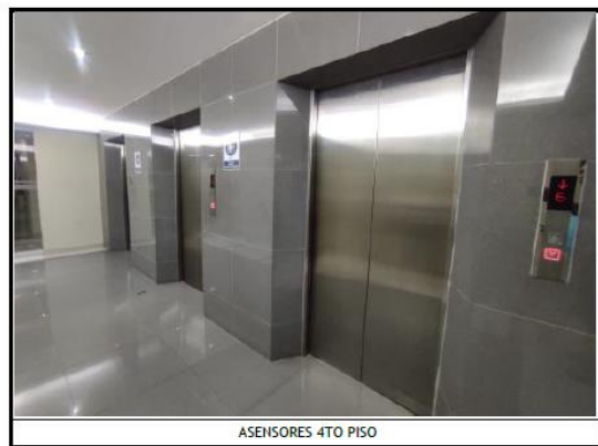
ASENSORES 4TO PISO
