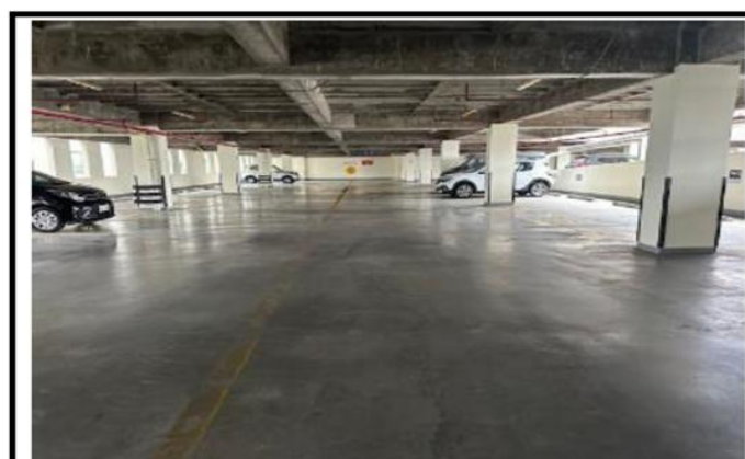
AREA DE CIRCULACION
